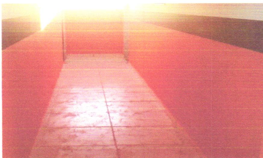
FOTO 01 – APLICAÇÃO MANUAL DE PINTURA COM TINTA LÁTEX ACRÍLICA EM PAREDES, DUAS DEMÃOS. AF_06/2014
