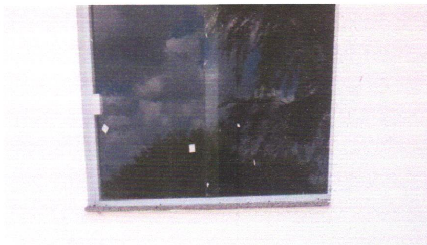
FOTO 02 – JANELA DE ALUMÍNIO DE CORRER COM 2 FOLHAS PARA VIDROS, COM VIDROS, BATENTE, ACABAMENTO COM ACETATO OU BRILHANTE E FERRAGENS. EXCLUSIVE ALIZAR E CONTRAMARCO. FORNECIMENTO E
